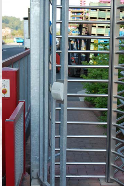
Drehkreuz mit Zutrittskontrolle
