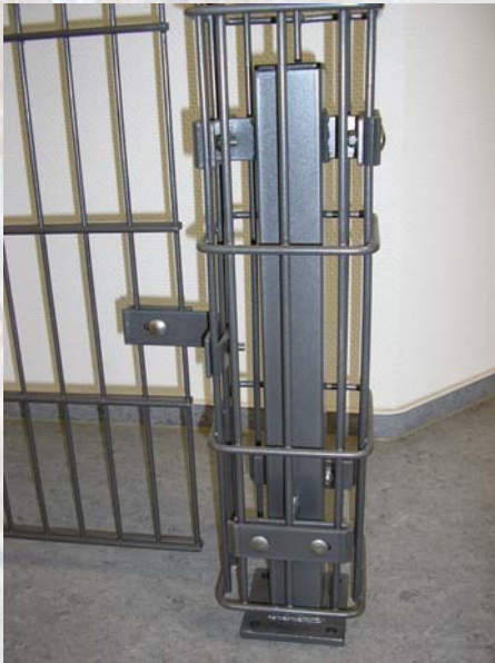
Befestigung der Ranksäule am Bodenanker
